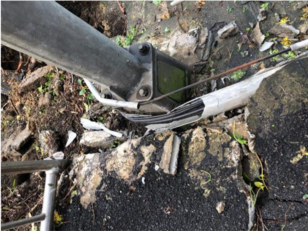
圖 7-7 災害區 108 年 09 月 30 日電管拉扯情形
