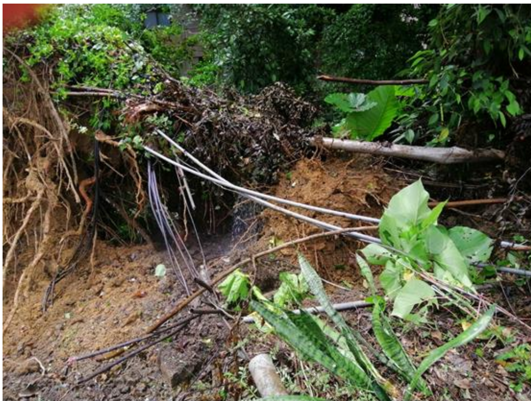
圖 7-4 災害區 108 年 09 月 29 日水管、電管扯斷情形
